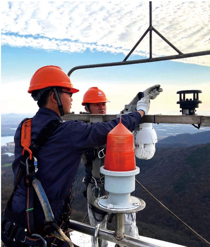
員工在風機機艙外安裝全域攝影機
