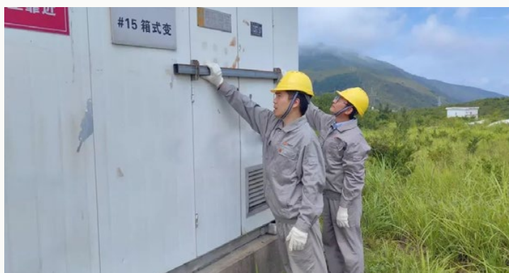
龍源浙江公司蒼南鶴頂山風電場員工提前對戶外箱變加裝固定橫杆
