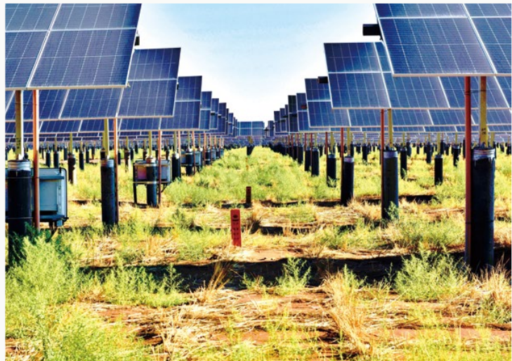
宁夏腾格里沙漠新能源基地项目一期生态修复效果显著
